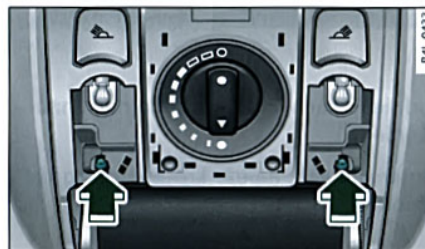
Rys. 52 Fragment tapicerki dachu: wykręcanie panelu oświetleniowego
